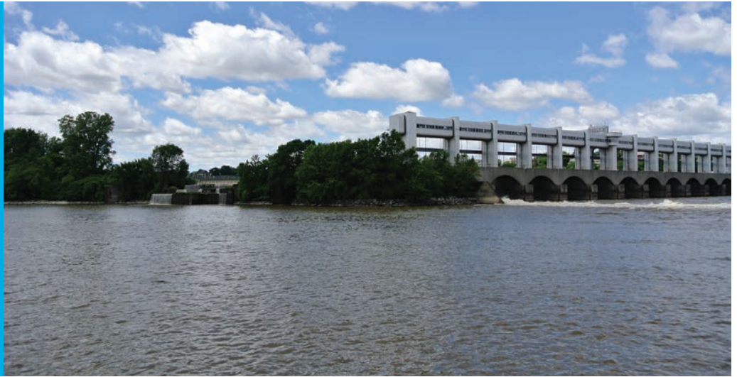
CENTRALE HYDROÉLECTRIQUE DE LA RIVIÈRE-DES-PRAIRIES
