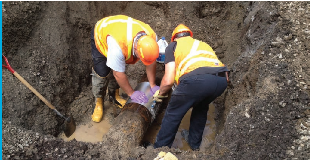
RÉPARATION D'UNE FUITE
